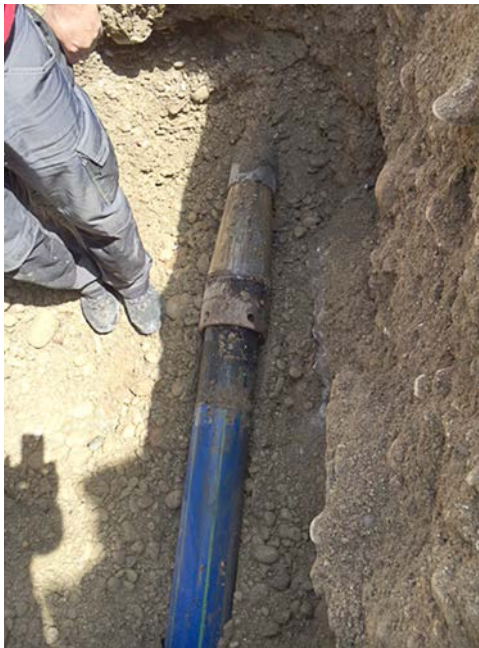
Das neue Rohr wird eingezogen.
