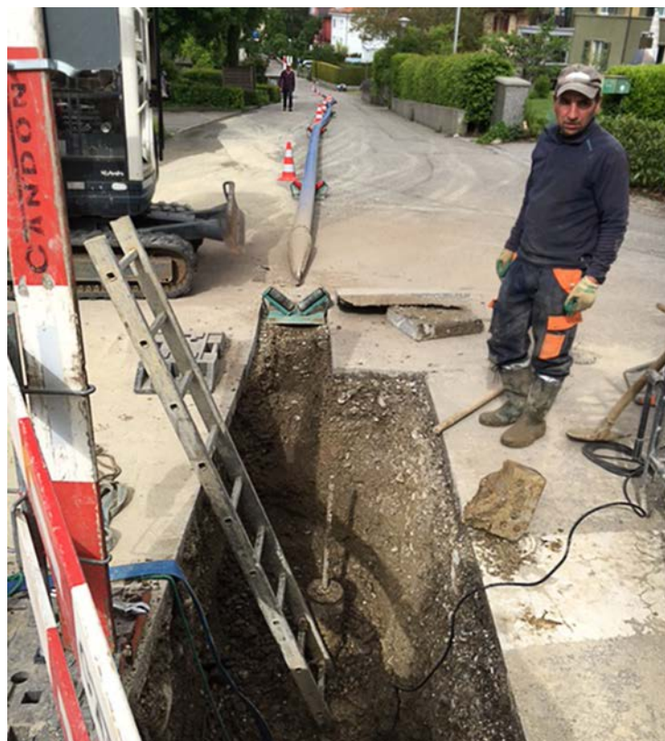
Die Startbaugrube mit der neuen Leitung im Hintergrund.
