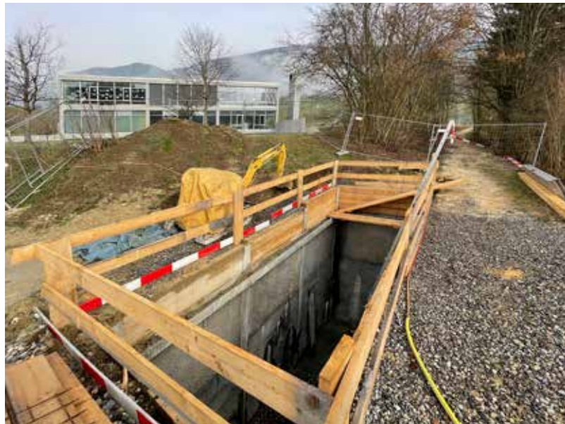
Erneuerung der Verbindungsleitung von der Quellfassung der Widlisbachquelle zur Brunnstube.
