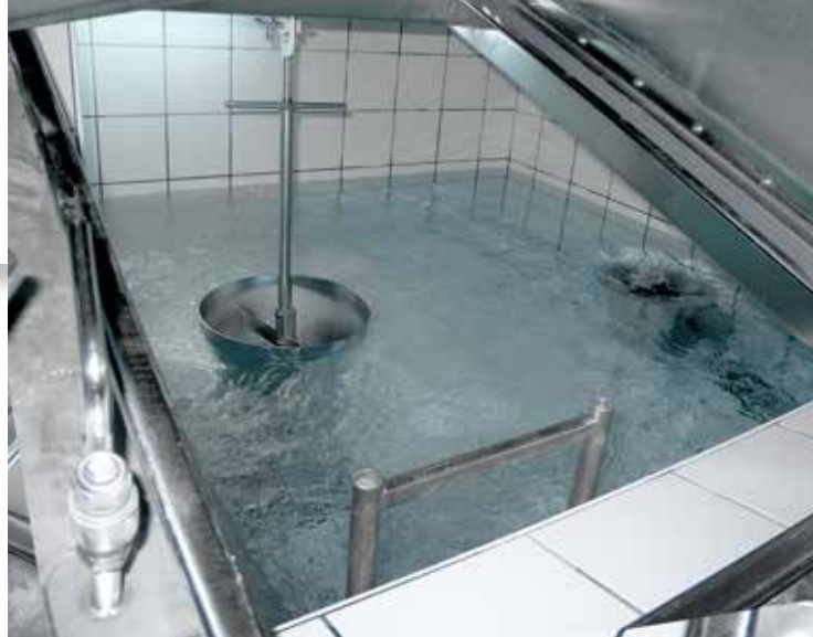
Quellfassung der Widlisbachquelle
