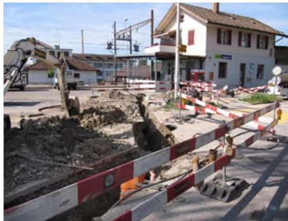
Leck in der Zuleitung zum Bahnhof. Ein provisorischer Anschluss ist bereits erstellt (30. Juni 2009).
