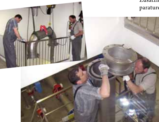
20 cm ergeben zusätzliche 100'000 Liter Löschwasser.
